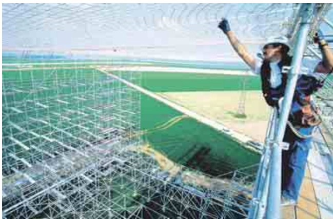
Un cliché qui met à l'honneur le secteur des BTP, visible à l'exposition Et voilà le travail, les bâtisseurs en Seine-Saint-Denis , aux Magasins généraux d'Aubervilliers : «Echafaudage pour les réparations du réseau EDF, après la tempête de 1999.»
