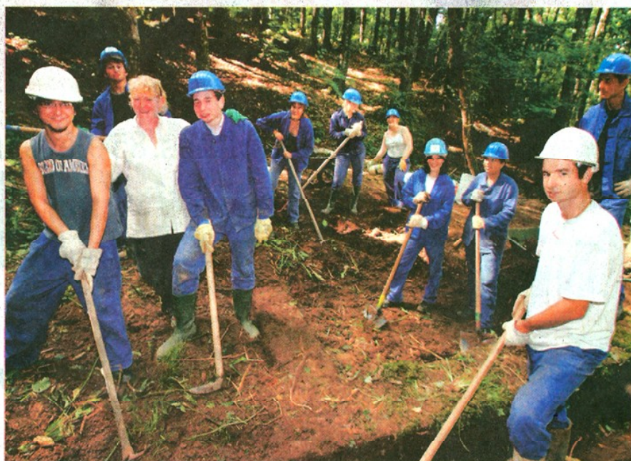
Les étudiants ont décidé de restaurer un lavoir mis à jour en débroussaillant. Photo DDM.J.-M.L.
